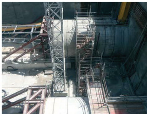
Doha - metro (Qatar)
