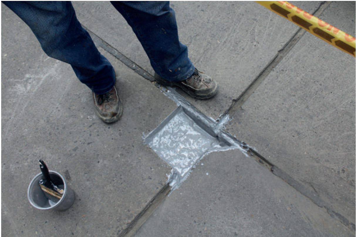
Figura 9. Reparación parcial de junta con Epotoc 1:1
