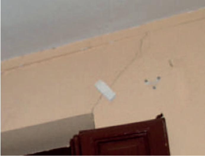
*Testigo de yeso instalado en fisura*
