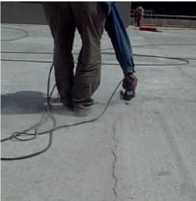
*Ranura sobre la fisura con una cortadora manual para concreto*
