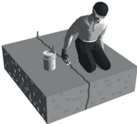
Para secciones de concreto mayores de 305 mm (12 pulg.), se puede necesitar un tiempo de aplicación mayor con una viscosidad menor, conforme la grieta disminuye de tamaño.
