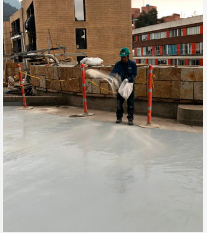
Colocación del EUCOFILLER VEHICULAR sobre MONO PRIMER hasta saturarlo completamente
