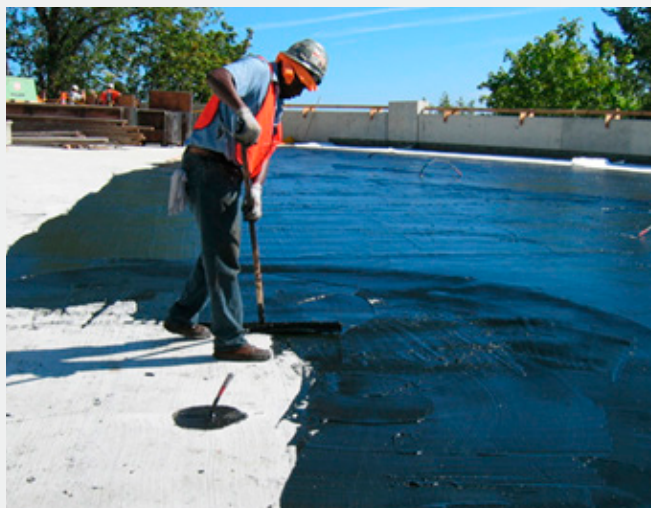
Aplicación de TREMproof® 250 GC LV con squeegee sobre la superficie
