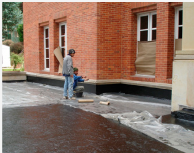
Colocación de protección de TREMproof® 250 GC LV con plástico de 6 mils de espesor
