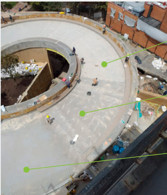
Proceso de colocación de sistema de impermeabilización VULKEM 350 NF + MONO PRIMER + EUCOFILLER VEHICULAR
