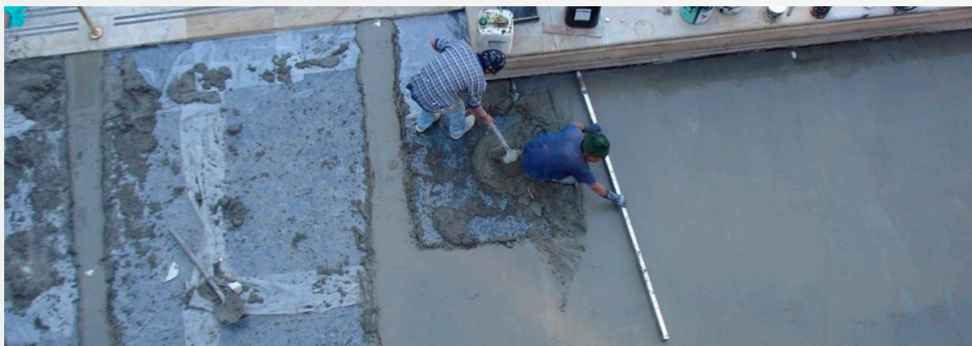
Colocación de mortero de nivelación sobre impermeabilización con TREMproof® 250 GC LV, protegida con plástico de 6 mils de espesor
