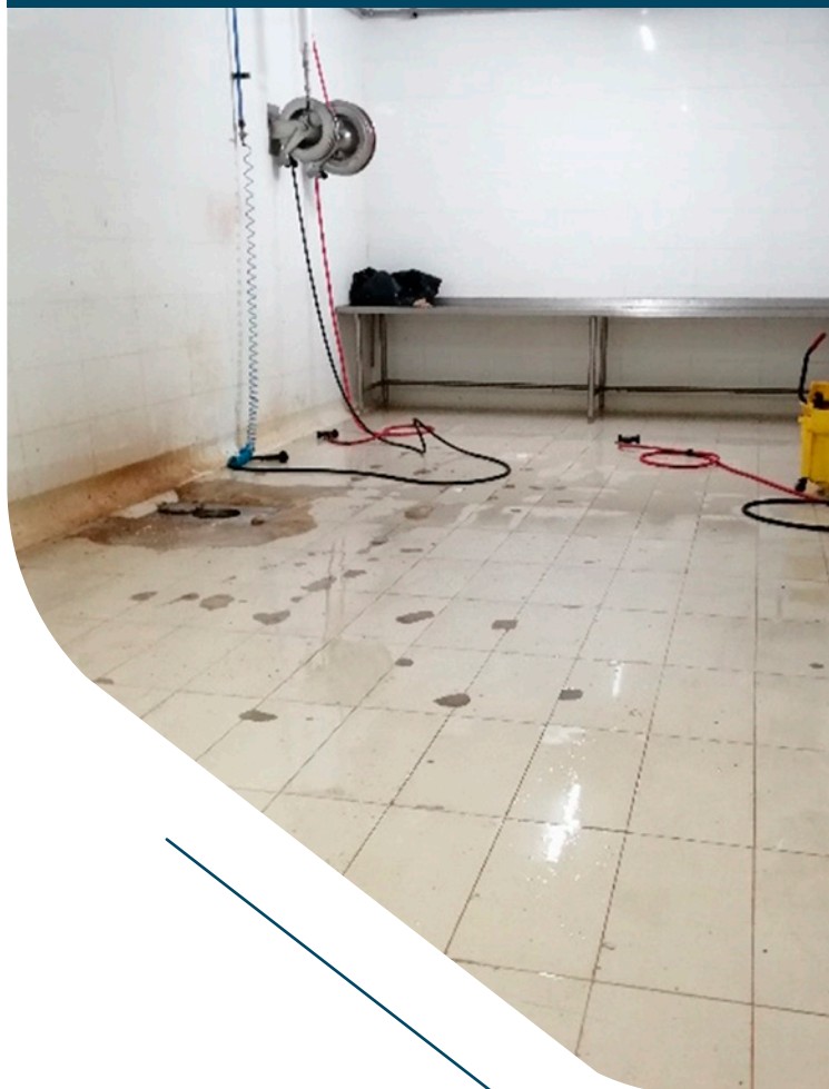
Fotos. Deterioro del sistema de baldosas en la industria.
