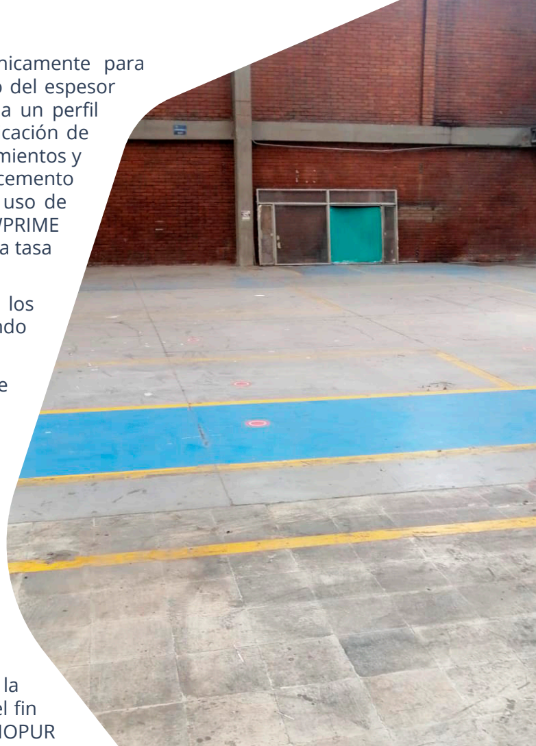
Foto. Correcta preparación de la superficie.
