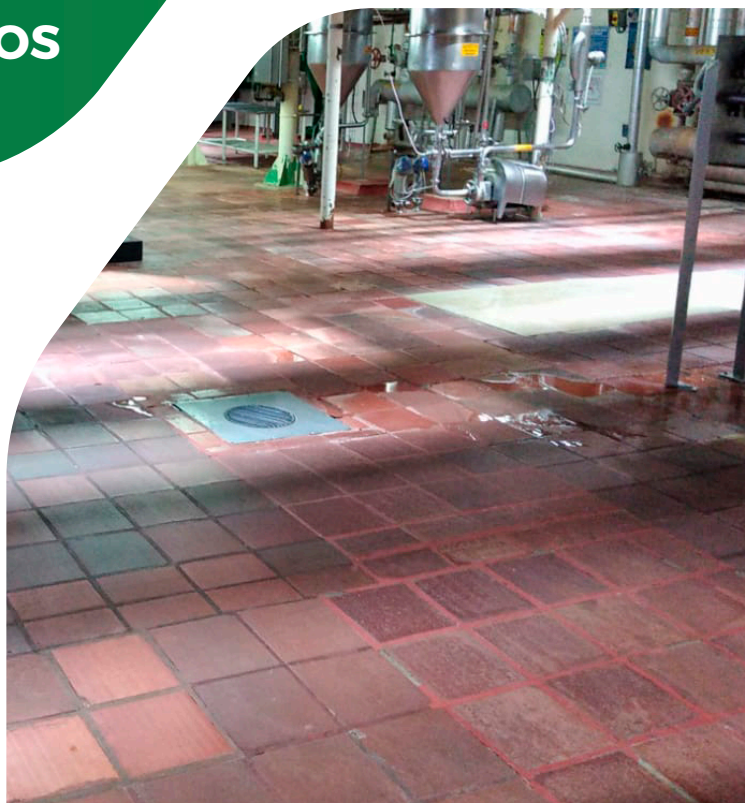
Fotos. Deterioro del sistema de baldosas en la industria.
