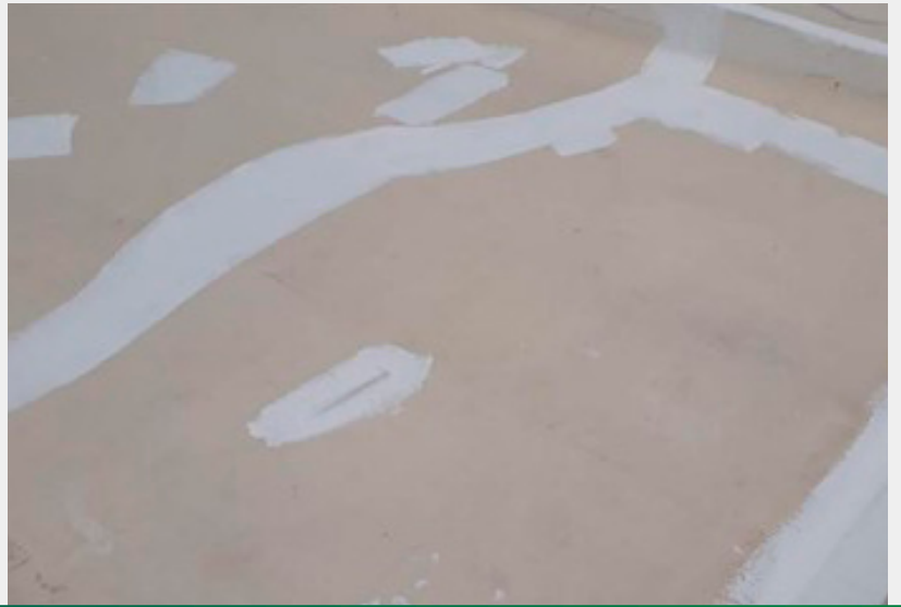
Refuerzo de fisuras tratadas con una capa de AQUAZERO
