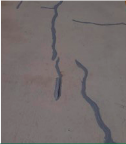
Tratamiento de fisuras con Vulken 45 SSL
