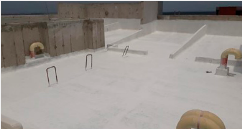
Superficie con capa de imprimación aplicada
