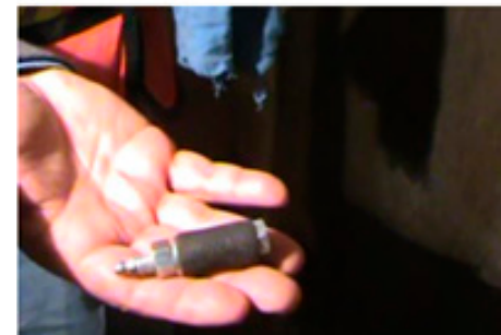
Hacer perforaciones de forma diagonal (45°), colocación de puertos de inyección en los barrenos y/o en los puntos donde se tenga la fuga activa para poder atravesar la junta fría.
