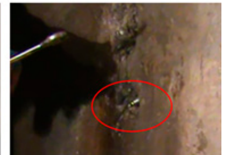
Hacer perforaciones de forma diagonal (45°), colocación de puertos de inyección en los barrenos y/o en los puntos donde se tenga la fuga activa para poder atravesar la junta fría.
