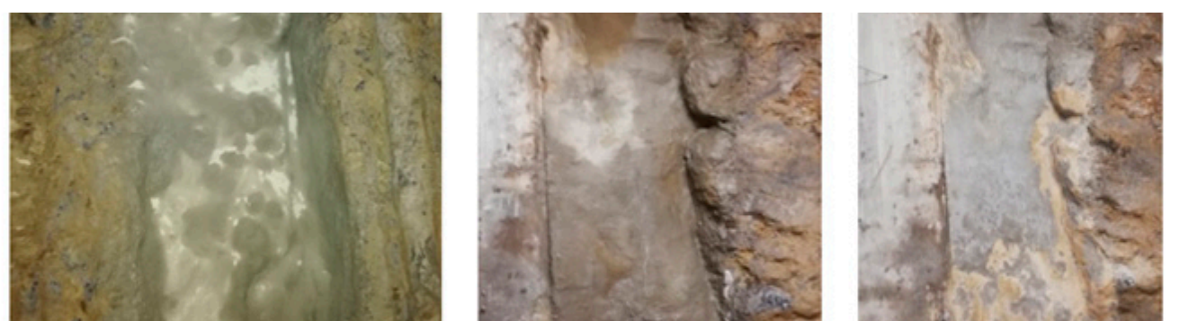
Estado inicial / Colocación de puertos y confinamiento / Inyección con Dural Aqua Dam LV / Aplicación Vandex / Muro totalmente seco.
