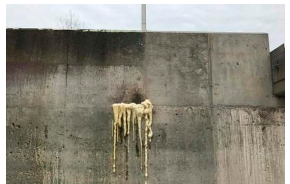
Filtración crítica en sótano. / Sellado de fisuras en tanque en servicio. / Reacción del grout químico base uretano.
