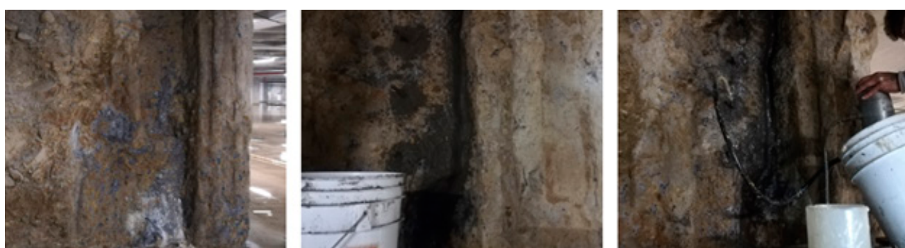
Estado inicial / Colocación de puertos y confinamiento / Inyección con Dural Aqua Dam LV / Aplicación Vandex / Muro totalmente seco.
