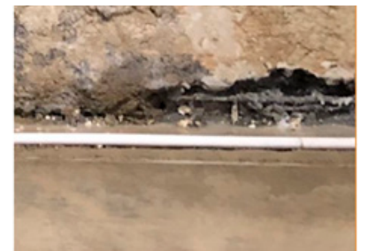
Determinar la geometría, uso de herramienta de corte, retirar y reparar la corrosión en acero (Si se presenta) y abrir la oquedad o junta, en donde se tiene la fuga activa.
