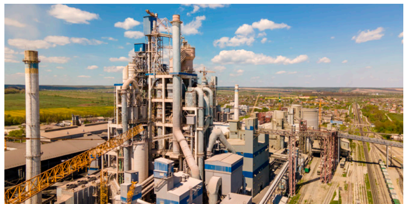
Vista aérea de fábrica de cemento.
