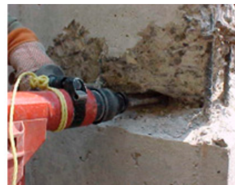
Determinar la geometría, uso de herramienta de corte, retirar y reparar la corrosión en acero (Si se presenta) y abrir la oquedad o junta, en donde se tiene la fuga activa.
