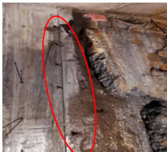
Una vez colocado los puertos de inyección, taponar con VANDEX PLUG o HEY'DI POWDER las oquedades, para concentrar la salida de agua sobre los puertos.
