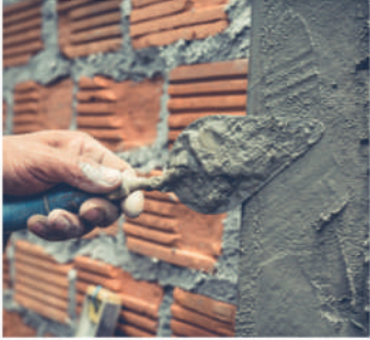
Donde se requiere un mortero impermeable, para pañetar muros
