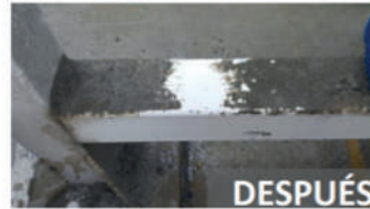
Limpieza de estructuras metálicas
