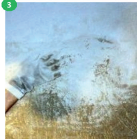
3 Aplicar con mano enguatada HEY'DI POWDER X seco, sobre el EURO SEALING LIQUID húmedo.
