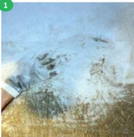
1 Aplicar con mano enguatada HEY'DI POWDER X seco, sobre la superficie húmeda.
