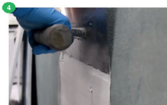
4 Ahora la superficie esta lista para que los acabados se adhieran adecuadamente a la superficie, sin necesidad del uso del cincel, decapado químico o inhibidores de fraguado superficial
