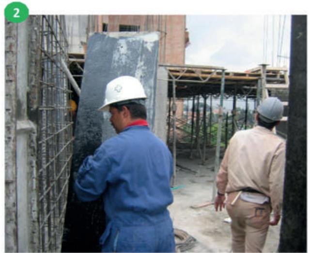
Colocar la formaleta y fundir el concreto
