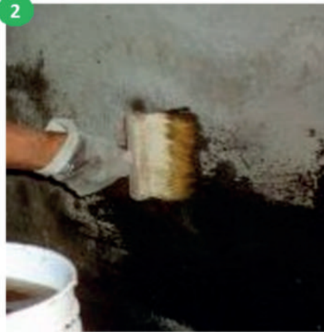
2 Aplicar con una brocha EURO SEALING LIQUID sobre toda la zona donde se aplico el HEY'DI POWDER X, cubriéndolo completamente.
