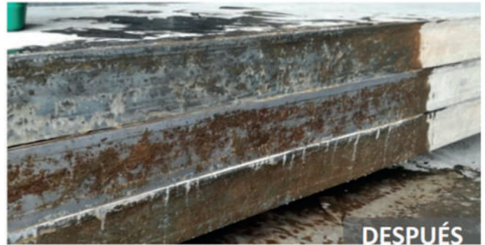
Limpieza de formaletas
