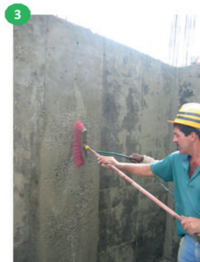
Luego de retirada la formaleta lavar con una escoba y agua
