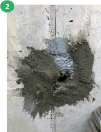
2 Aplicar el EUCOLISTO con llana o espátula en espesores de 0.5 cm hasta 4 cm máximo.
