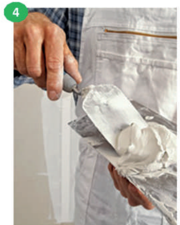
4 Luego de 2 horas de aplicado el EUCOLISTO se puede estucar la superficie si se desea dar un acabado más estético.
