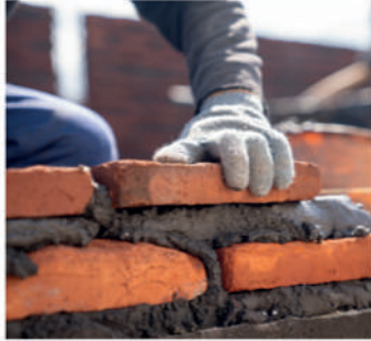
Para pega de mampostería a la interperie
