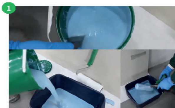
1 Mezclar homogenizando el producto y empapar el rodillo
