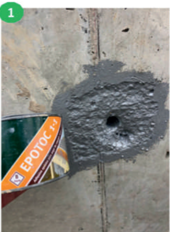
1 Dar perfil de rugosidad a la zona a reparar y si es necesario aplicar el adhesivo epóxico EPOTOC .
