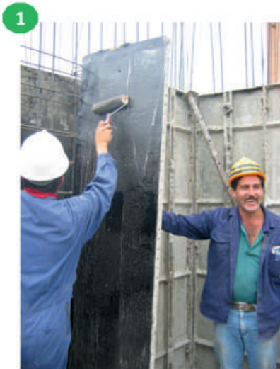
Sobre la formaleta limpia, aplicar EUCO TEXTURA PLUS con rodillo
