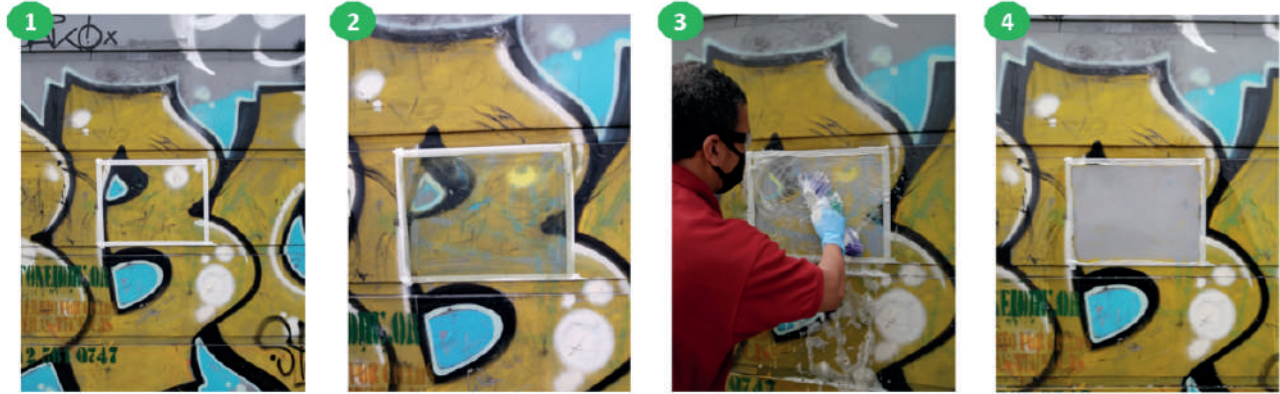
1 Demarcación del área a tratar
