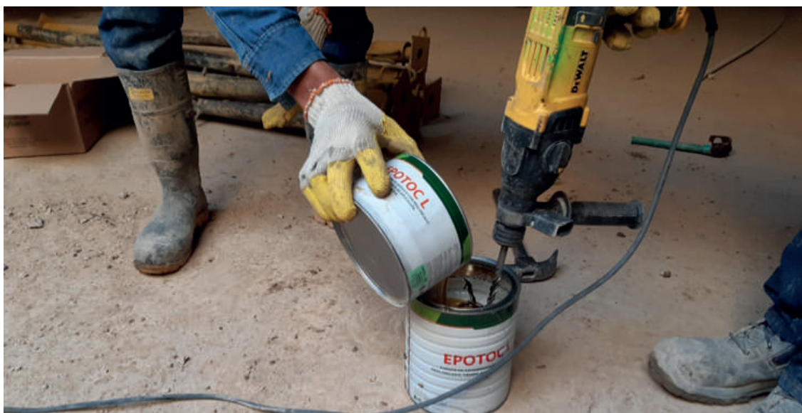
Figura y. Aplicación del Epotoc L
