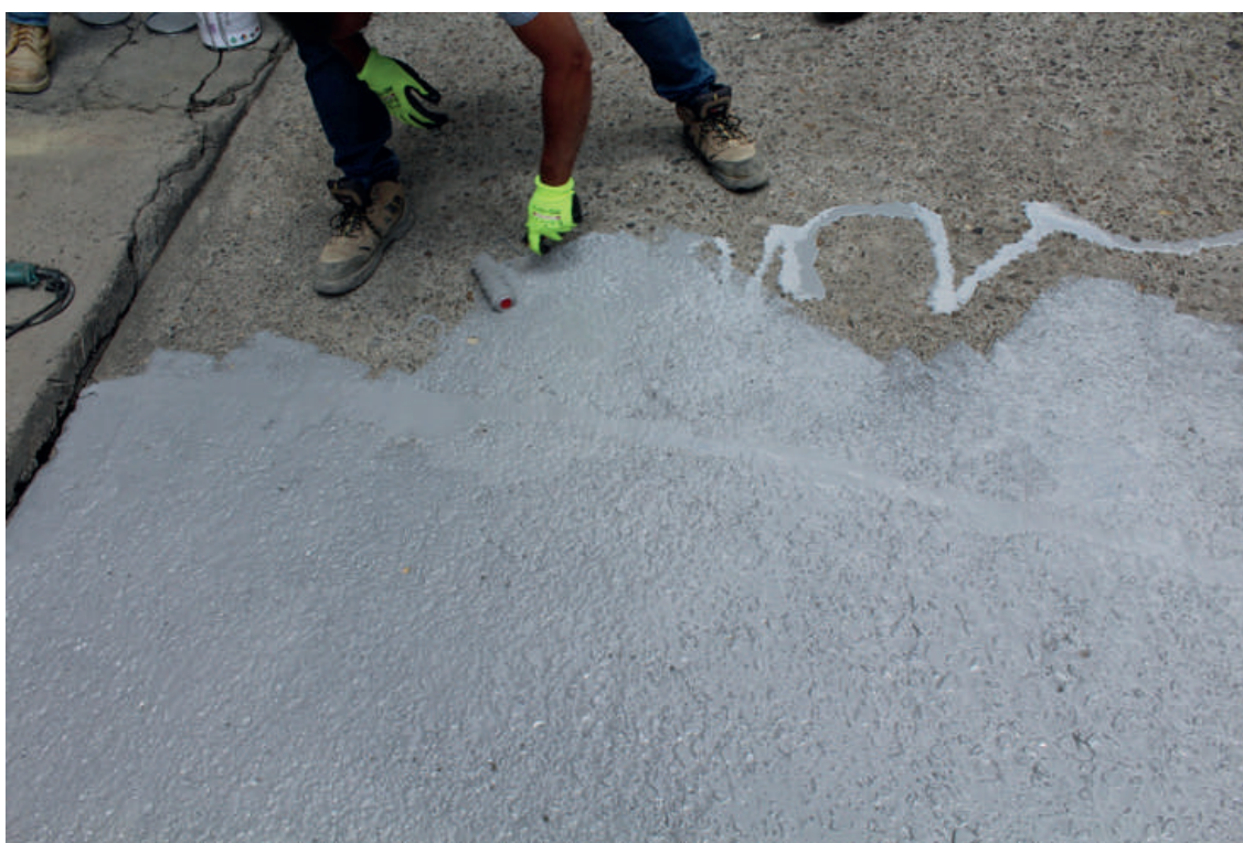
Figura y. Aplicación del Epotoc L
