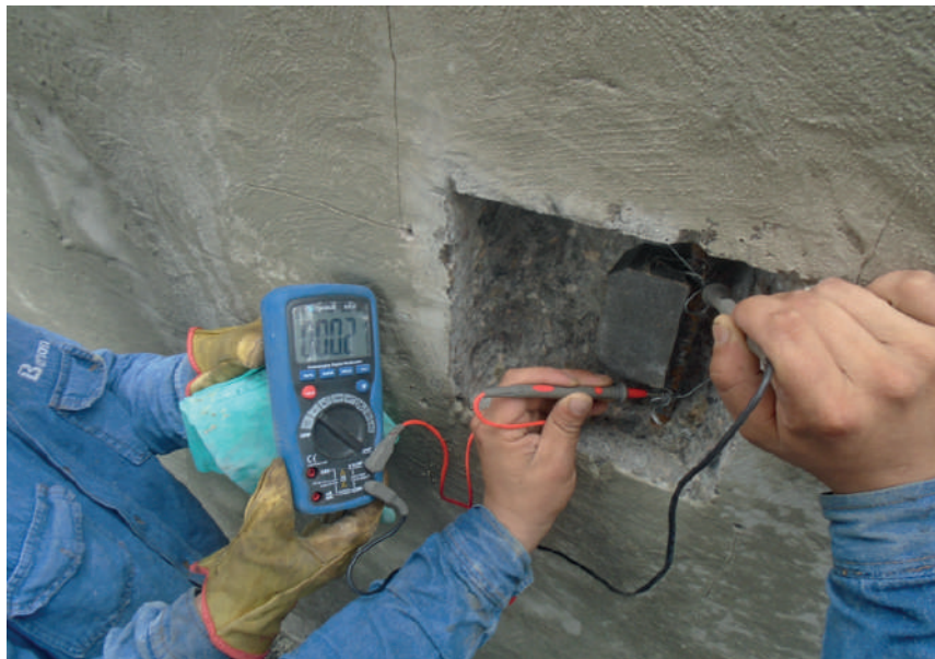
Figura 5. Instalación de ánodos de sacrificio
