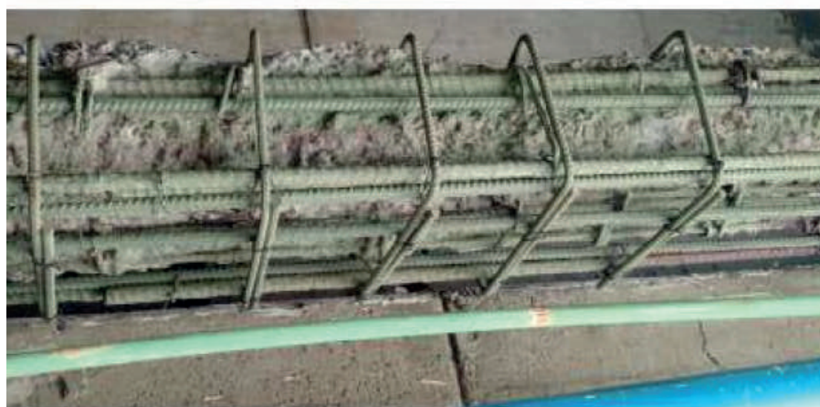
Figura 4. Acero de refuerzo recubierto con Toc Armadura
