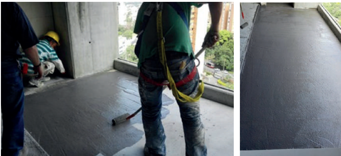
Figura 6. Aplicación sistemas Eucoplus
