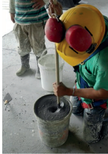
Figura 5. Mezcla de EUCOPLUS 5000 aplicación en balcón.
