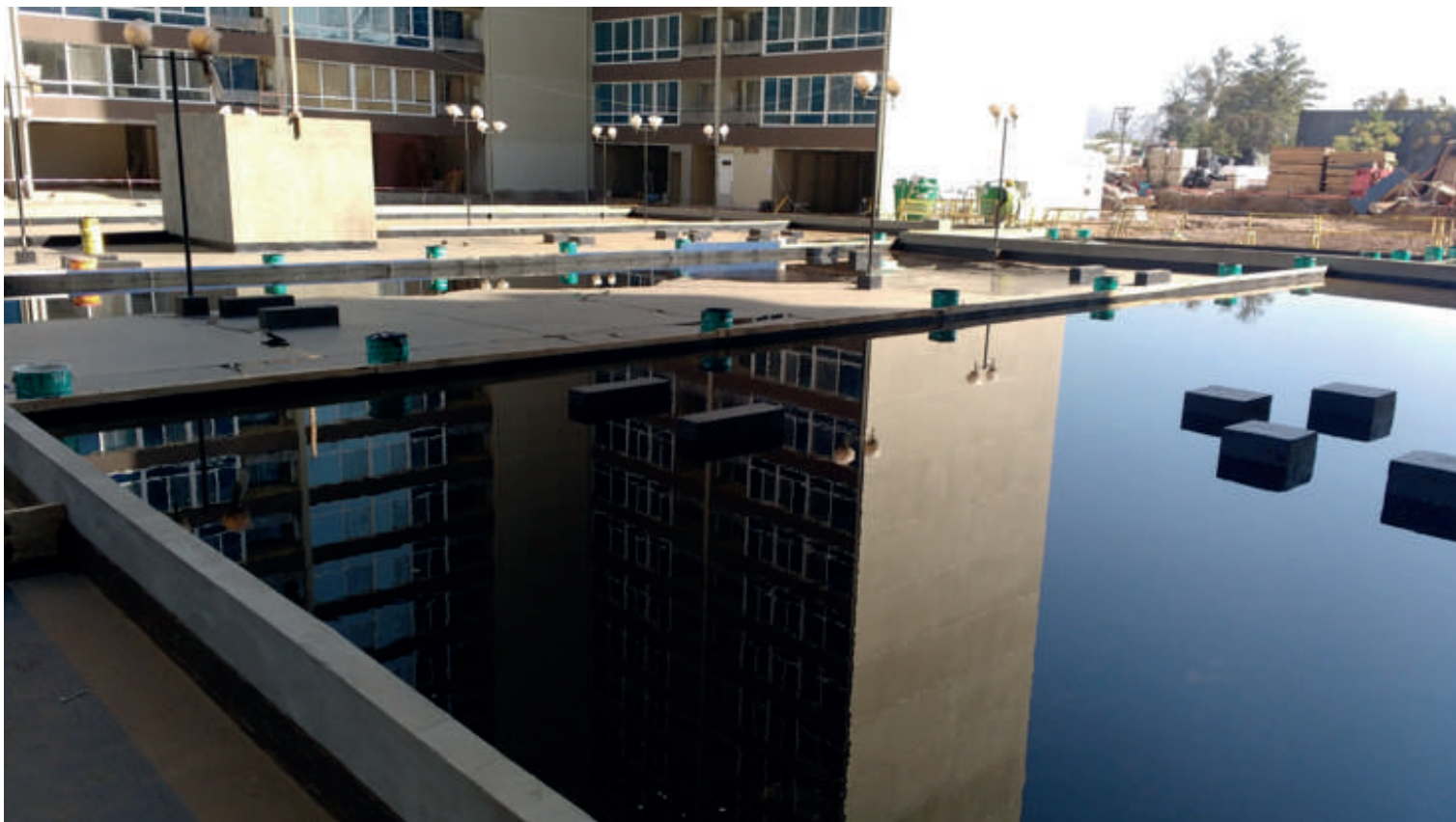
Prueba de estanqueidad en TREMPROOF 250 GC LV
