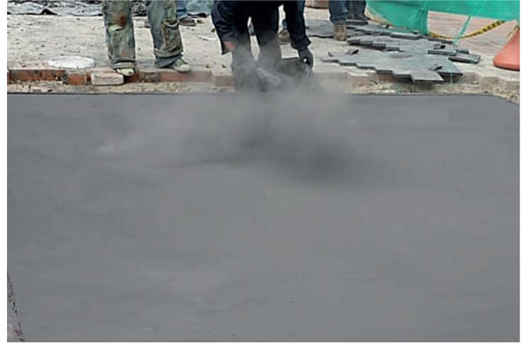
Se recomienda utilizar una combinación de color en la que el desmoldante sea más oscuro que el endurecedor para adicionar color y profundidad a la superficie, logrando un acabado natural. No se recomienda el uso de desmoldantes neutros.
