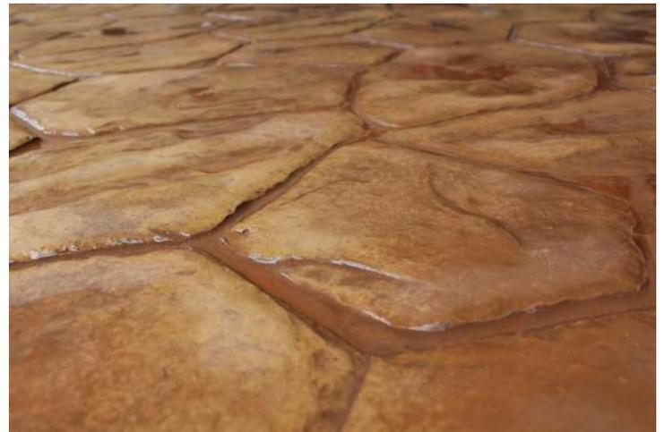
Las juntas se deben cortar según el diseño establecido teniendo en cuenta el tiempo de fraguado del concreto, profundidad de la placa, etc. (ACI 302).
