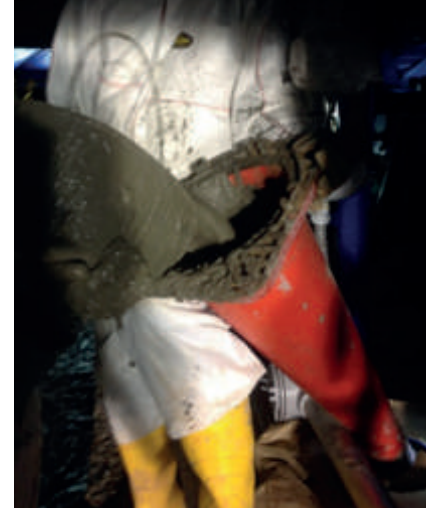
Vaciado de grout en base de equipo
