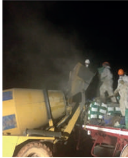
Mezcla de grout en mixer pequeña
