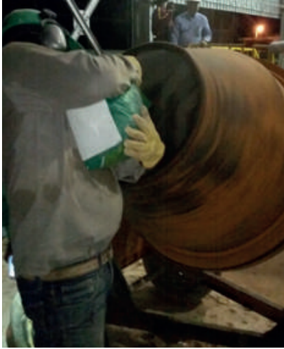
Mezcla de grout en trompo
