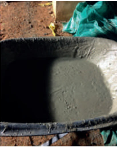
Grout ya mezclado vaciado en Carretilla para ser transportado
