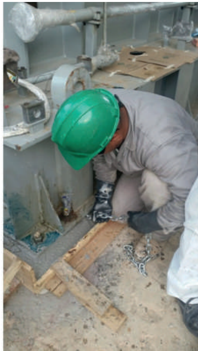
Uso de cadena para ayudarle al grout a acomodarse
