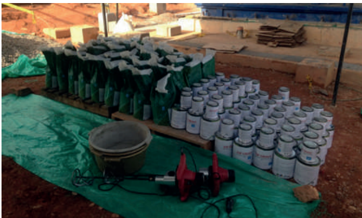
Alistamiento del producto y los equipos antes de la fundida.
