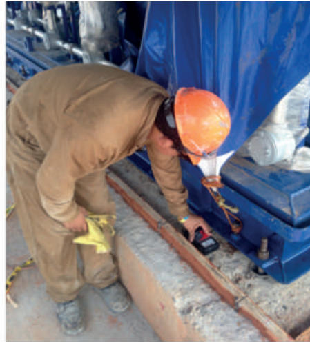
Verificación de la humedad en la superficie de concreto.
