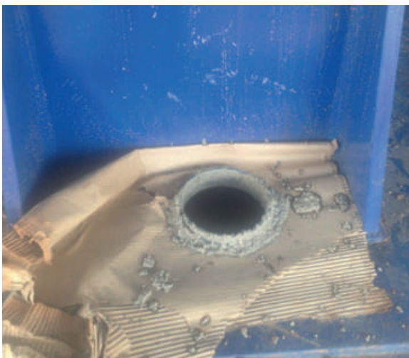
Protección del equipo alrededor de los orificios para la instalación de grout epóxico
