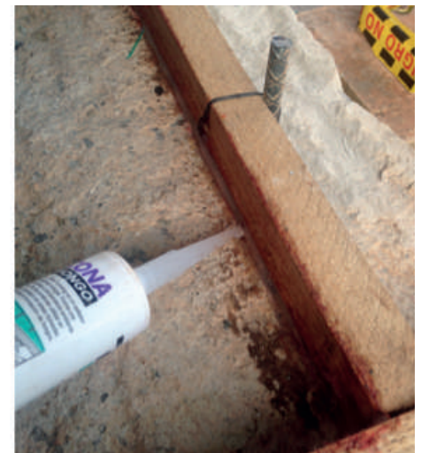
Sello de silicona en los bordes de la formaleta para evitar escape del grout
