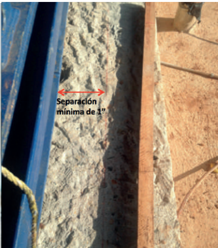
Demarcación de línea de guía para la colocación de formaleta
