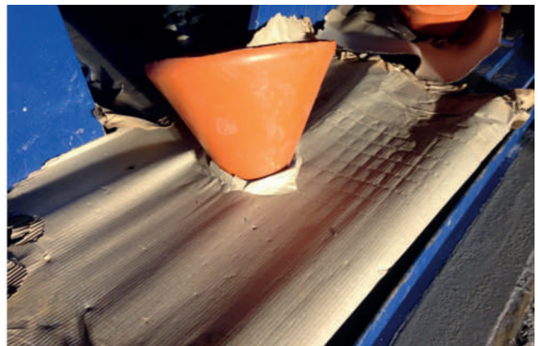
Protección del equipo alrededor de los orificios para la instalación de grout epóxico
