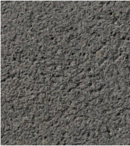
Superficie con perfil de rugosidad adecuado.
