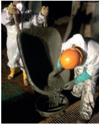
Grout colocado en valde para facilitar su vaciado
