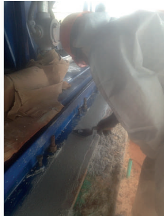
Acabado liso al grout con uso de palustre y solvente
