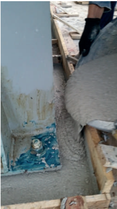
Vertimiento del grout dentro de la formaleta.
