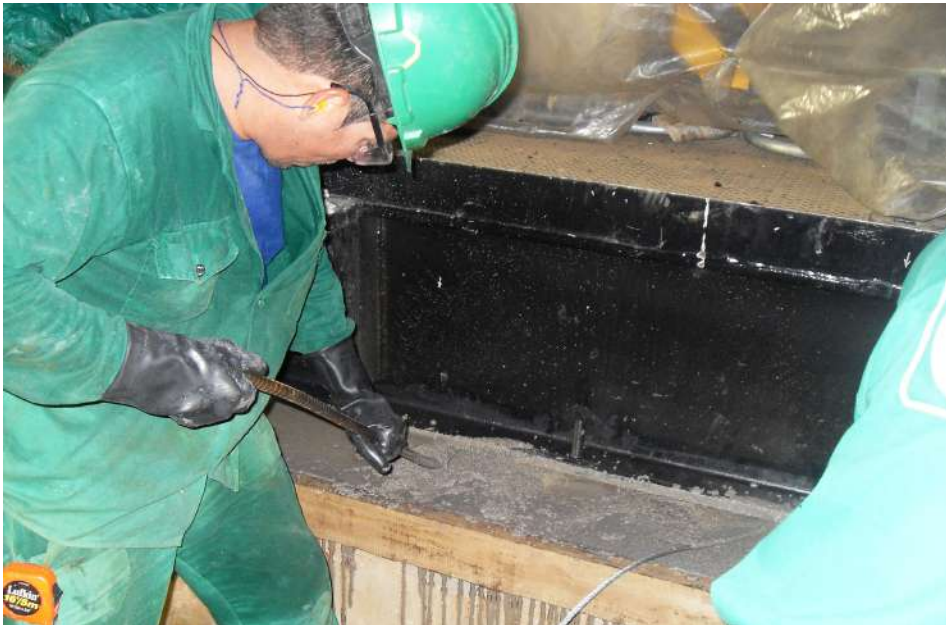
Acomodación de grout por medio de elementos mecanicos.
