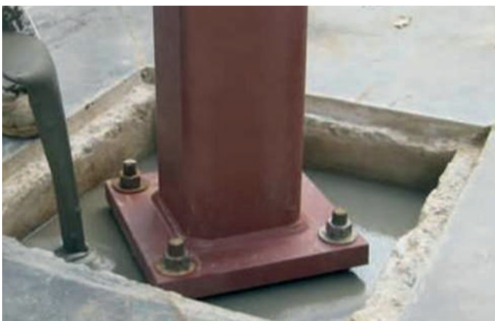
Colocación de grout cementicio
