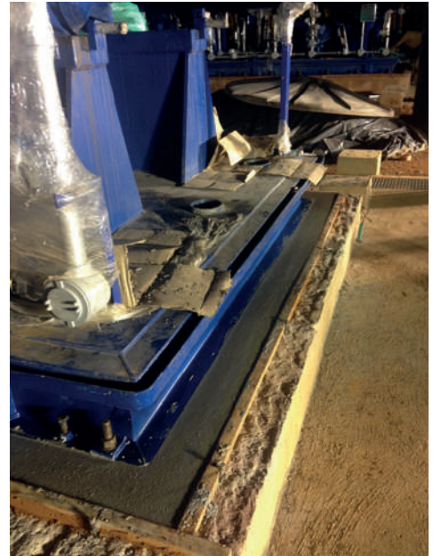
Acabado final de E3FGROUT en equipo.
