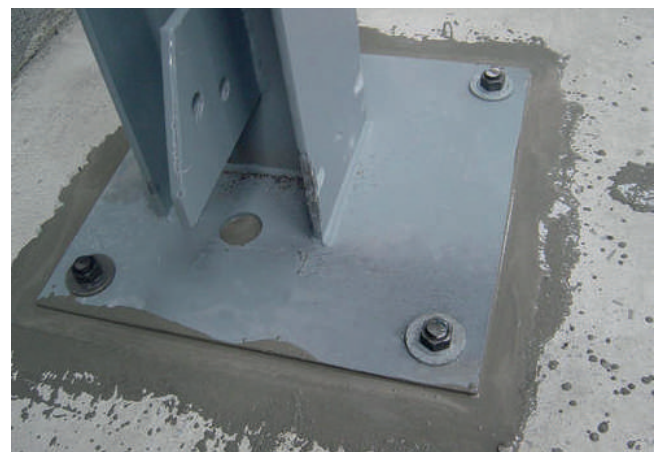
Pedestal de columna con grout cementicio
