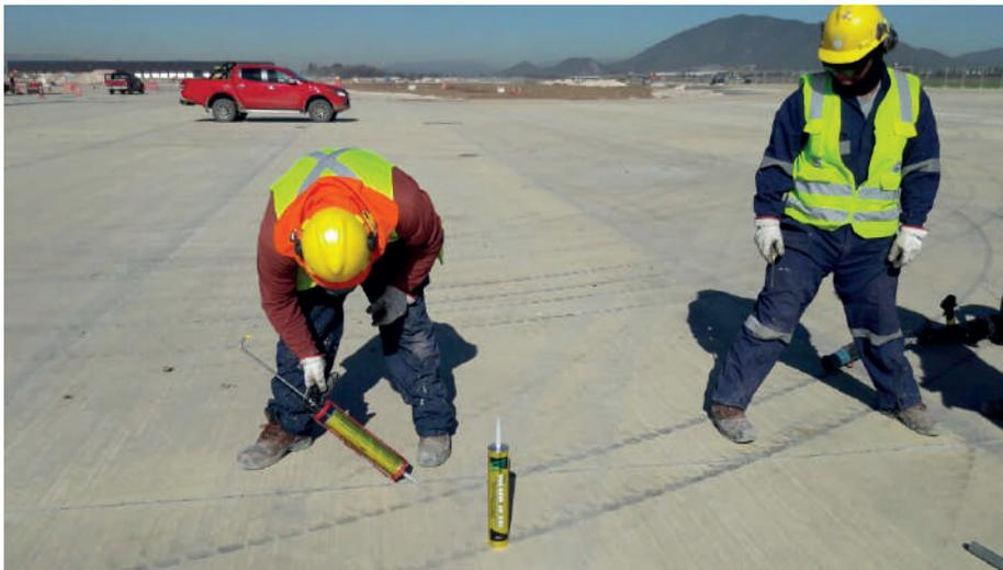
*Figuras 8 Y 9: Aplicación respaldo de junta de forma manual y equipo para colocación.*
