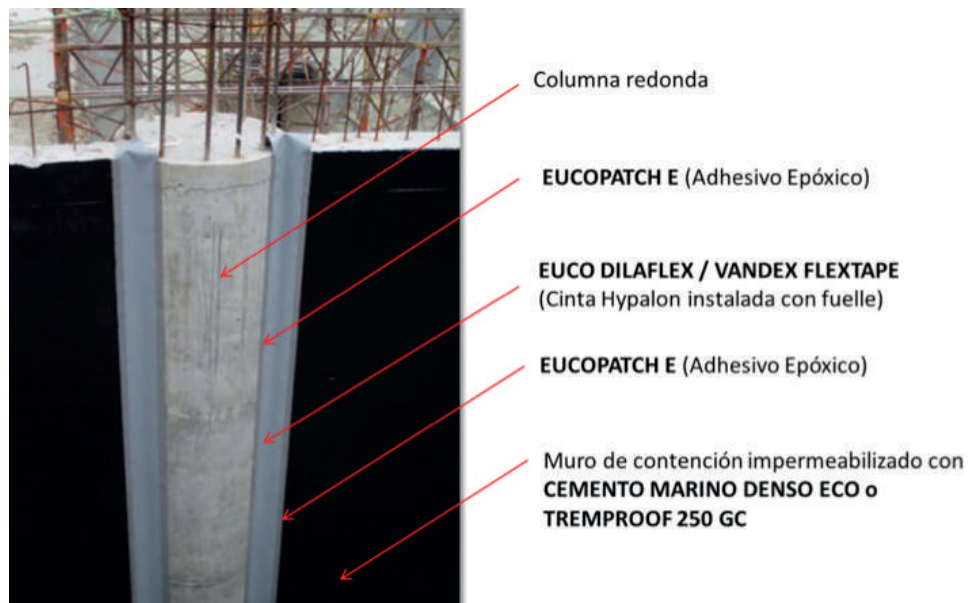
Junta EUCO DILAFLEX / VANDEX FLEXTAPE instalada entre una columna y un muro de contención.
