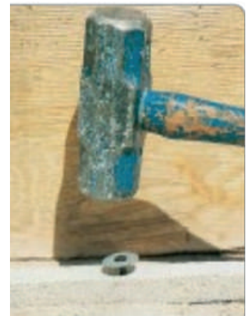
3. Se fija con puntillas cada 30 cm
