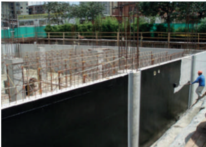
Aplicación de TREMproof® 250 GC LV R con rodillo en muros de contención
