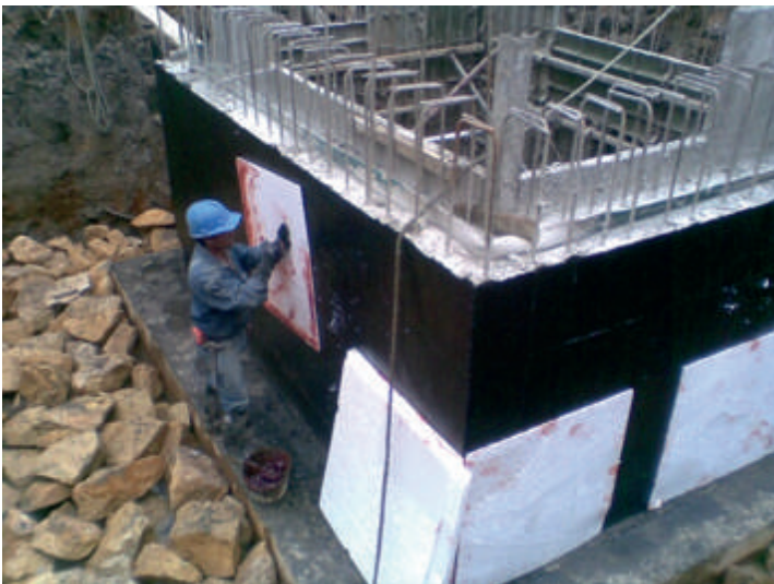
Colocación de la protección de la impermeabilización con icopor.
