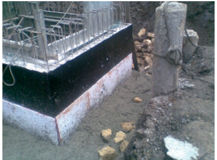
Relleno del terreno con la protección de la impermeabilización.
