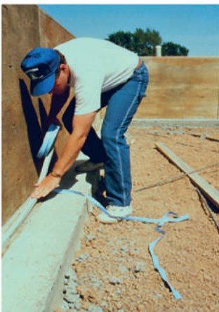
1. La superficie donde se va a colocar debe estar lisa y se retira la cinta de protección.
