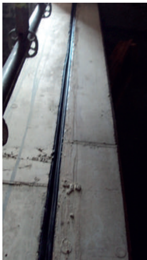
JUNTA JEENE instalada verticalmente en una junta de expansión estructural.
