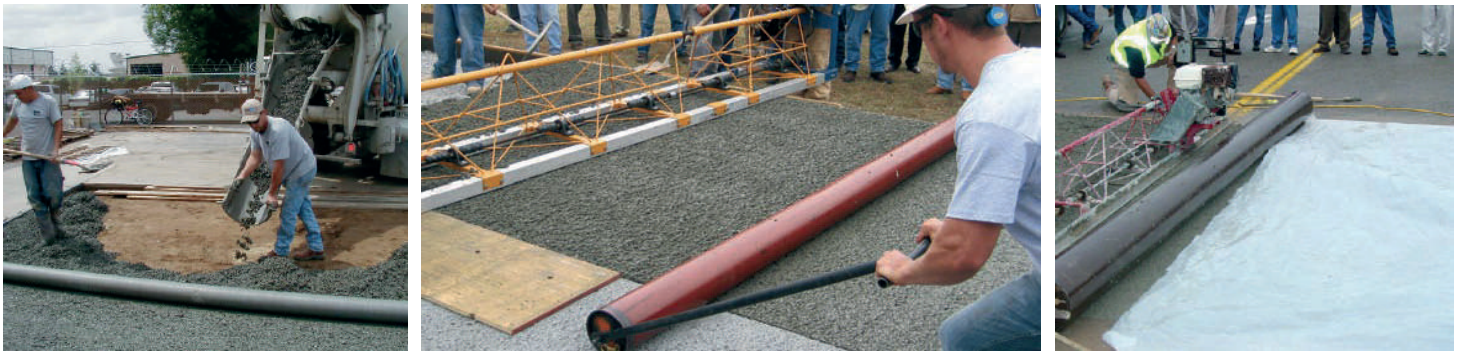
Colocación, compactación y curado del Concreto Porooso.
