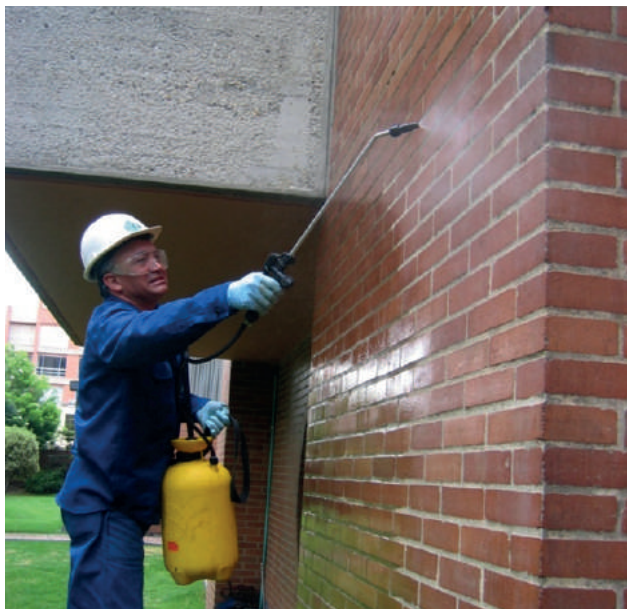
Aplicación de hidrófugo sobre fachada
