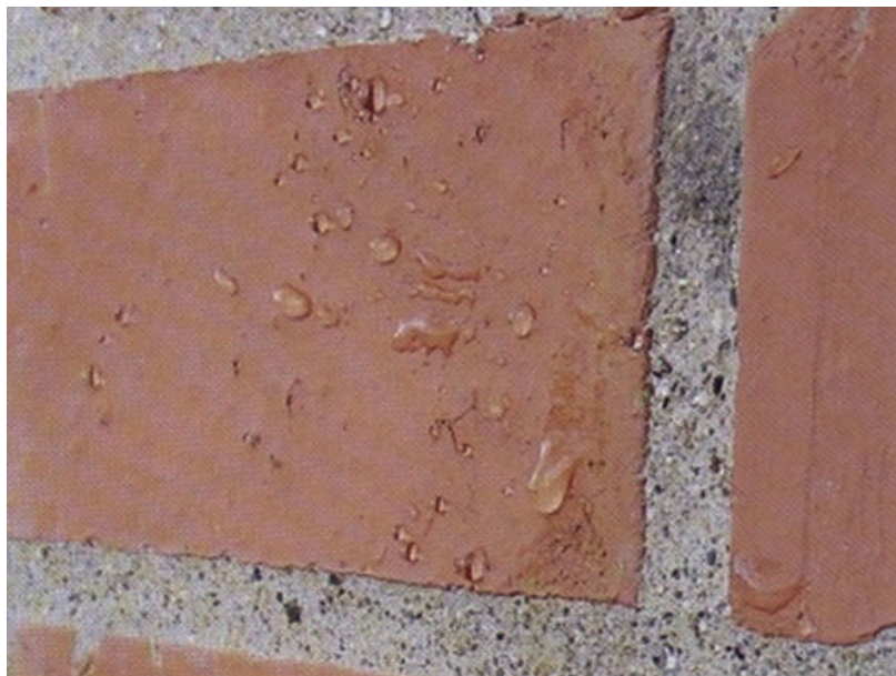
Efecto perlado de repelencia de agua sobre ladrillo hidrofugado
