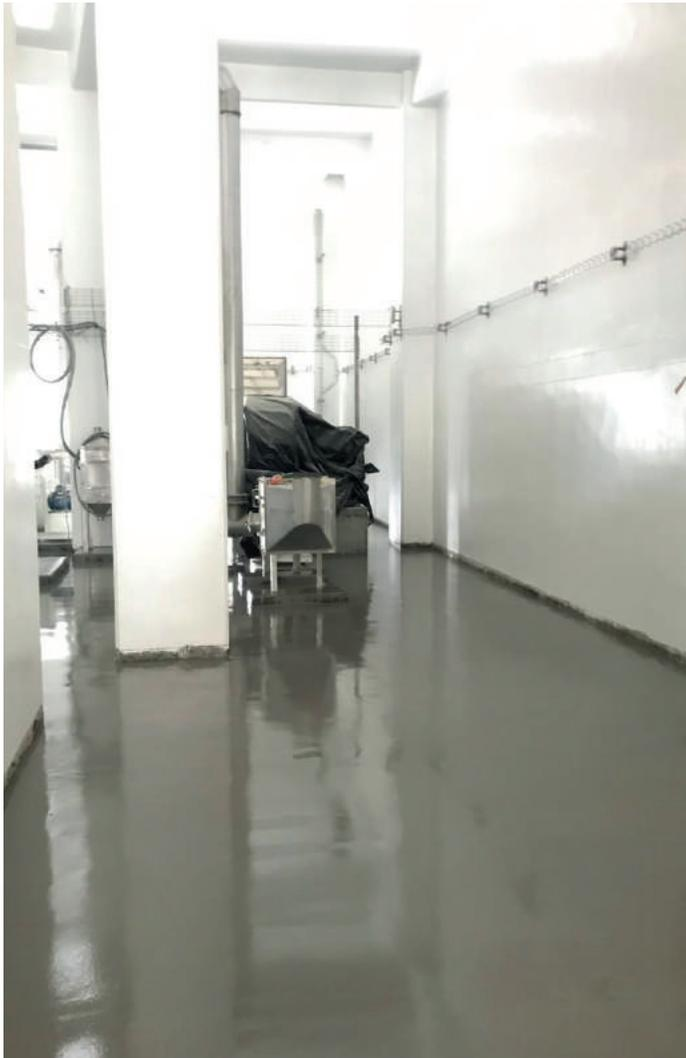
En la especificación se determina la aplicación de **MONOPUR INDUSTRY MORTAR** 6 mm, pero luego debido a las exigencias en cuanto a textura del piso y asepsia, se cambia la especificación a **MONOPUR INDUSTRY SL** 4 mm, el cual es aplicado en todo el proyecto debido a su acabado totalmente liso (autonivelante).
