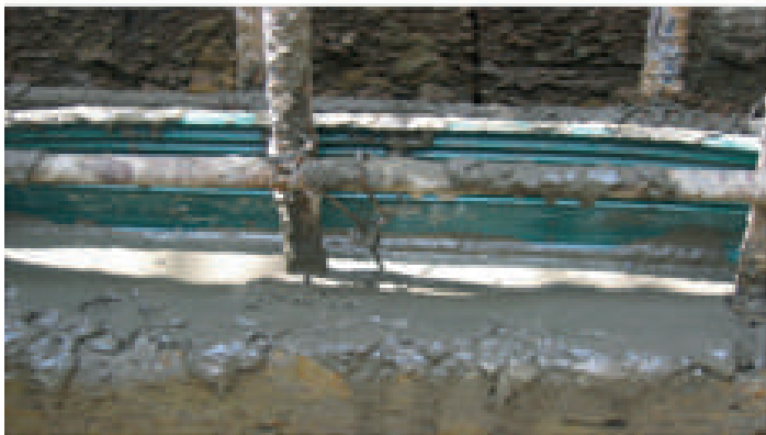
Adecuada instalación de la cinta PVC
