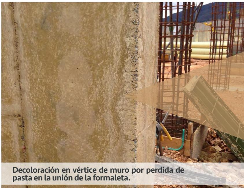
**Decoloración en vértice de muro por pérdida de pasta en la unión de la formaleta.**
