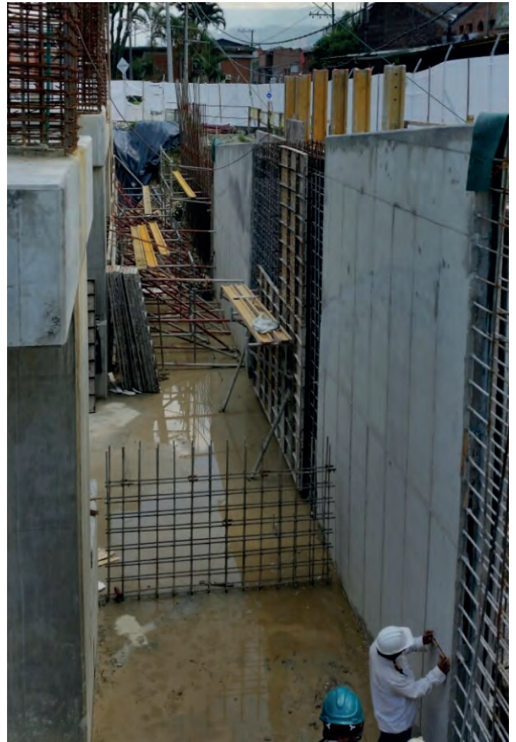
CONCRETO DE BAJA PERMEABILIDAD FIBERSTRAND N Y CINTA PVC
