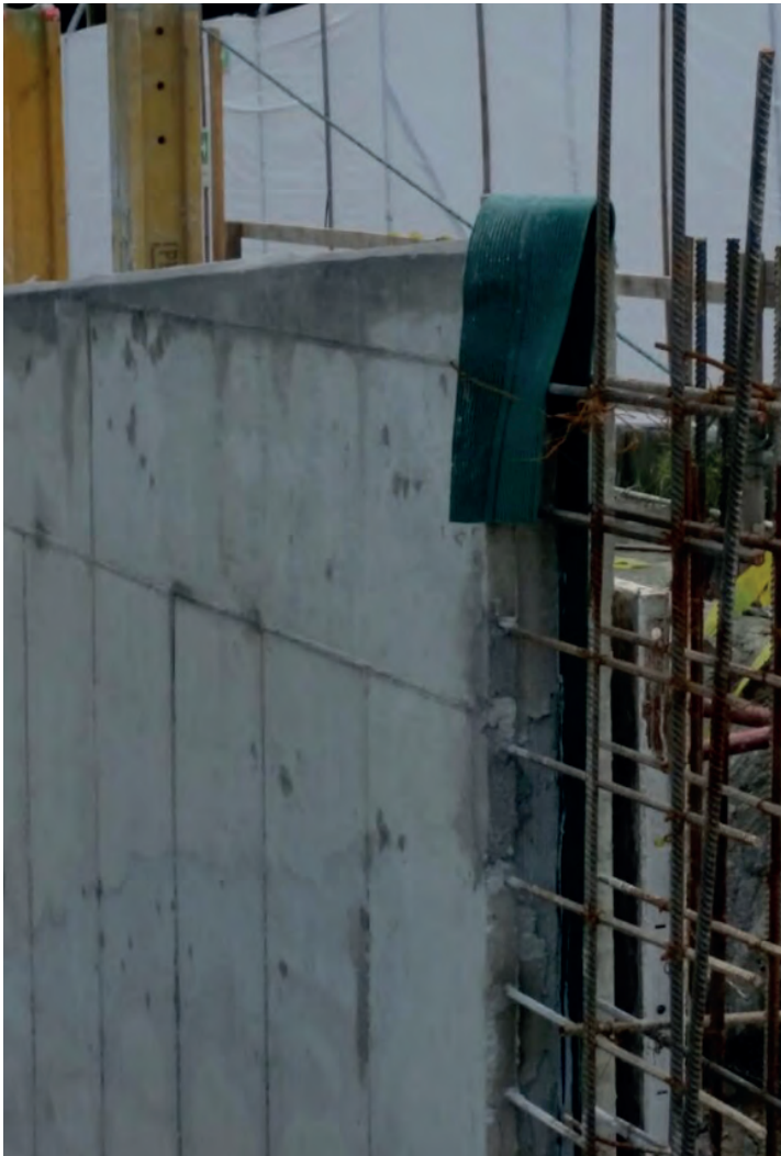
CONCRETO DE BAJA PERMEABILIDAD FIBERSTRAND N Y CINTA PVC
