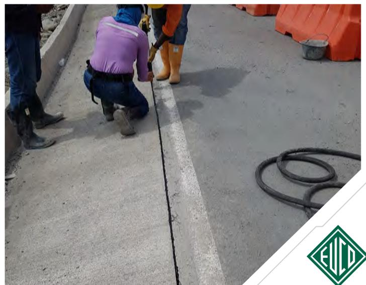
Producto para colocar como sello de junta entre carpeta asfáltica y cunetas de concreto en las vías de acceso de camiones a muelle granos.
